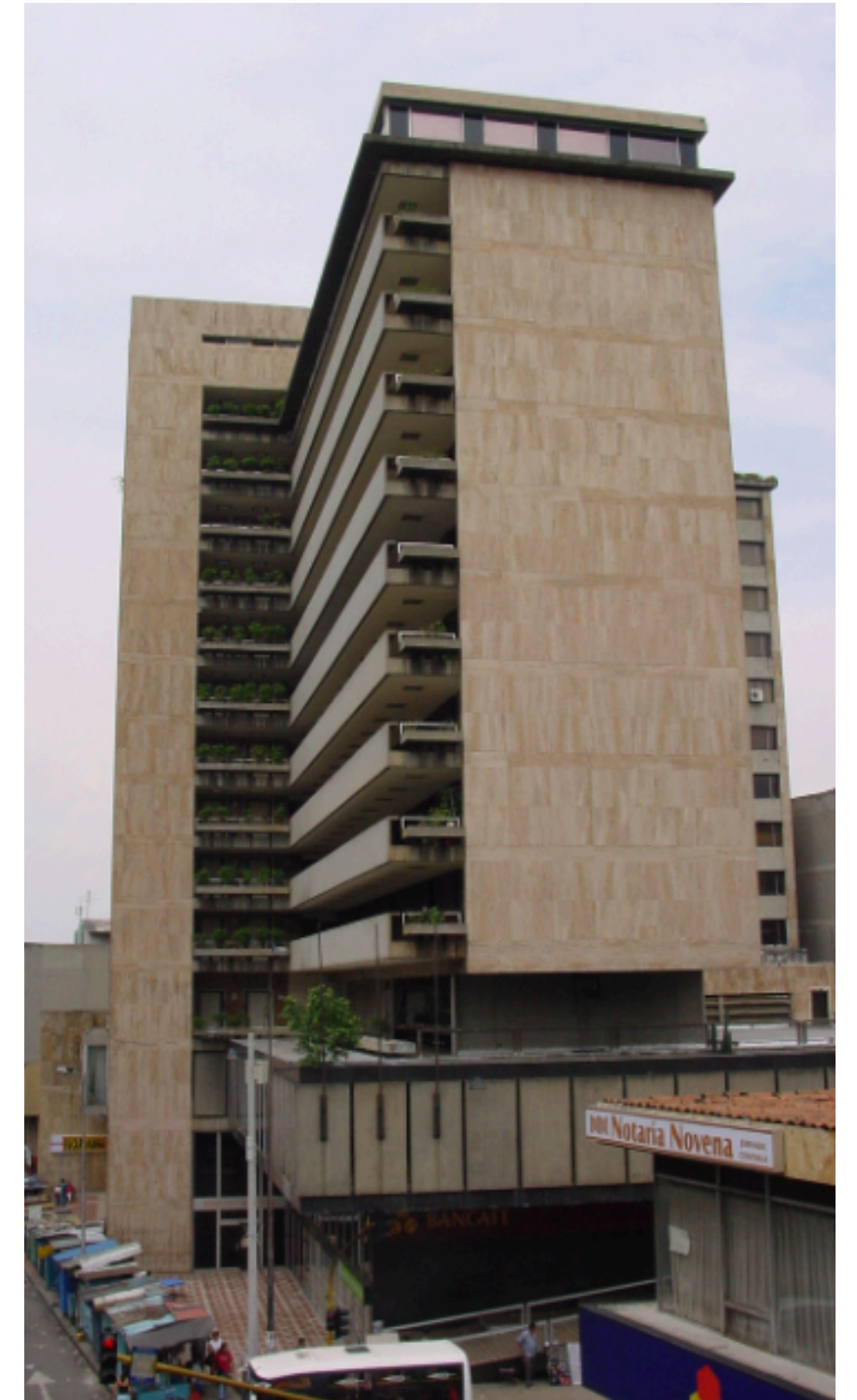
Edificio Banco Cafetero, Cali, Colombia. 1959 - 1962 Arquitectos Borrero, Zamorano y Giovannelli
