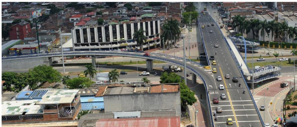
Figura 12. Intersección vial de la Carrera 44 con Autopista Sur (Suarez, 2017).
