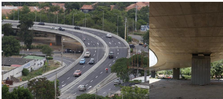
Figura 9. Intersección vial Redoma San Mateo. Izquierda: Vista general. Derecha: Pila típica (Suarez, 2017).
