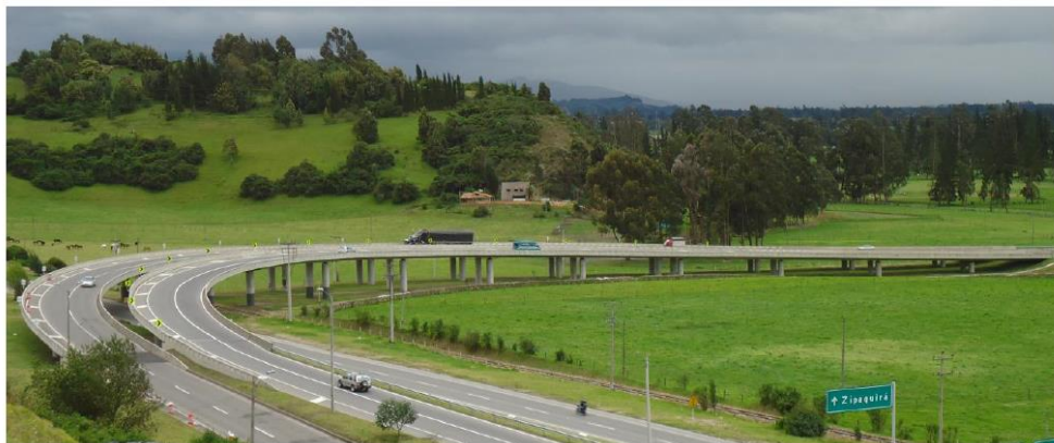
Figura 8. Viaducto Portachuelo (Suarez, 2017).
