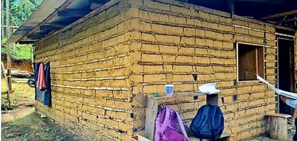
Figura 48 Vivienda en bareque relleno y latas
