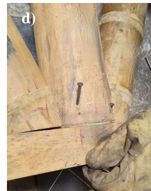
Figura 55 Detalle del proceso constructivo de las conexiones de las puntillas
