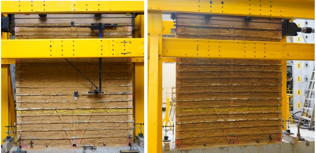
Figura 85 Montaje del muro TSHS en madera con latas de guadua y relleno de tierra
