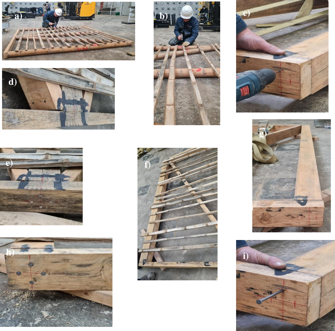
Figura 56 Detalle constructivo de la conexión de puntillas en madera
