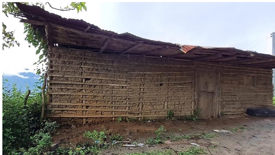
Figura 49 Vivienda en bahareque relleno con madera y latas
