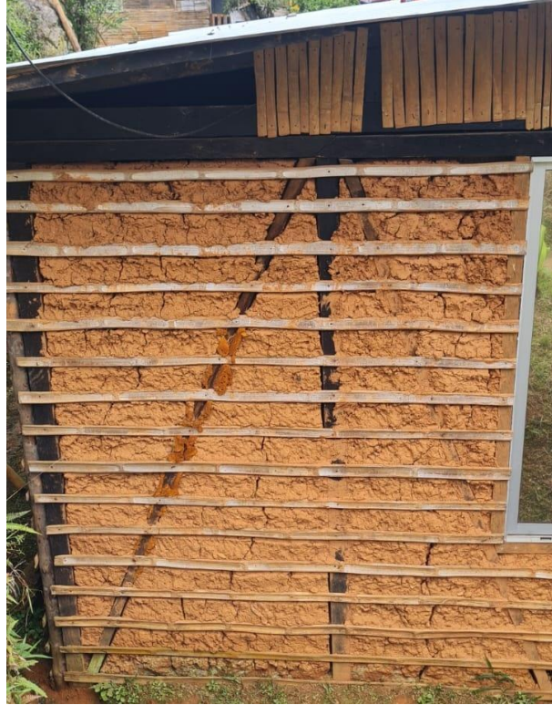
Figura 46 Vivienda típica con madera aserrada y latas de guadua.
