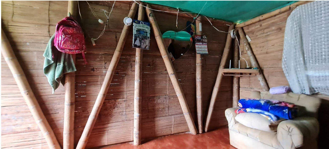
Figura 47 Casa construida de guadua y esterilla de guadua.
