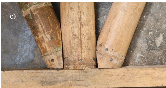
Figura 55 Detalle del proceso constructivo de las conexiones de las puntillas
