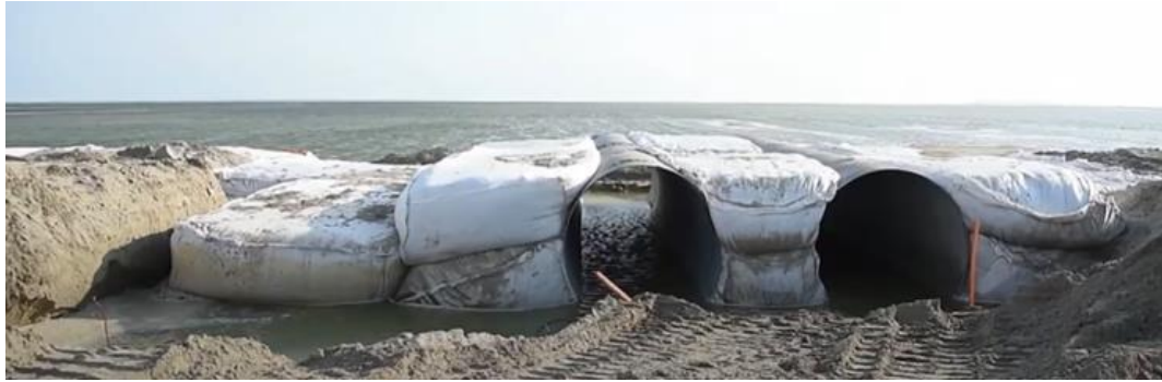
Ilustración 18. Ejemplo de bolsacreto para obras de control de erosión
