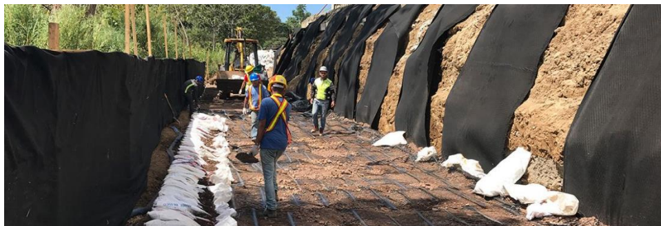
Ilustración 10. Instalacion de geodren planar
