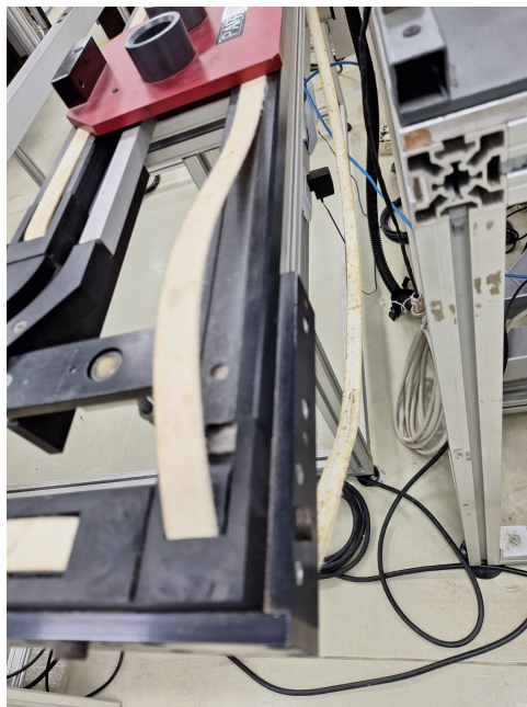
Figura 10.4: Daño en la correa de la banda transportadora
