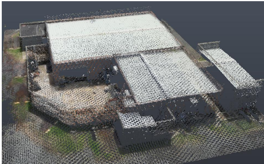
Figura 109. Vista general de la nube de puntos Dron LiDAR del Laboratorio de Mezclas perspectiva exterior. Fuente: elaboración propia.
