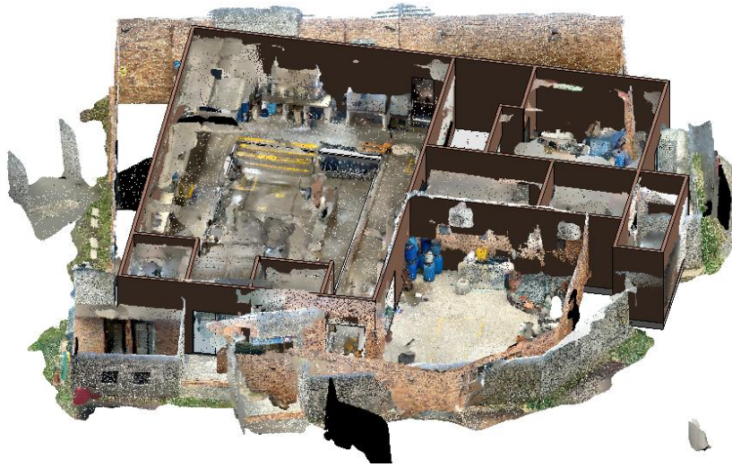
Figura 103. Vista general de la nube de puntos iPhone del Laboratorio de Mezclas perspectiva exterior e interior, rotación de la nube con esta técnica. Fuente: elaboración propia.
