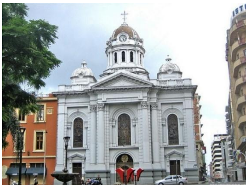
Figura 5. Catedral San Pedro Fachada principal (Arquidiócesis de Cali, 2015)
