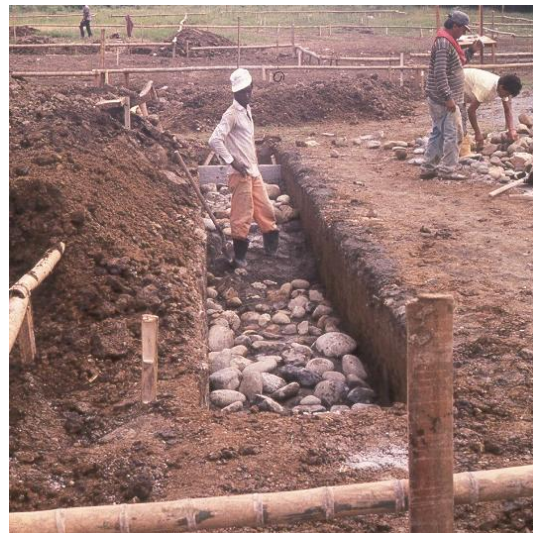
Figura 3. Soluciones para mitigar el efecto de los suelos expansivos en Santiago de Cali (Villafañe et al., 2000).
