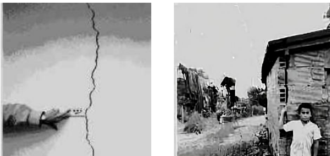
Figura 2. Grietas asociadas con deslizamientos en la vereda Mestizal (Cano y Otálvaro, 2000).
