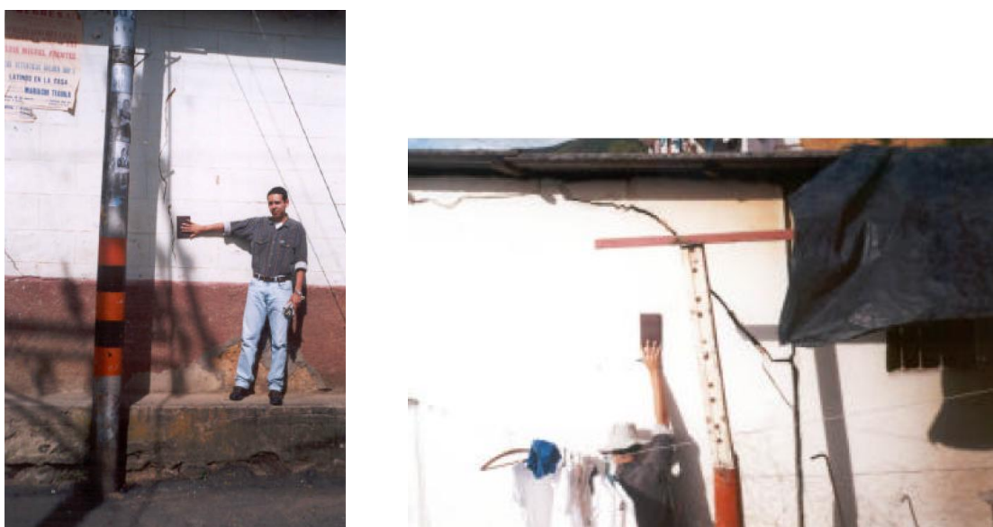
Figura 4. Daños visibles en el punto de descarga de cargas dinámicas por tránsito pesado (Cano y Otálvaro, 2001).
