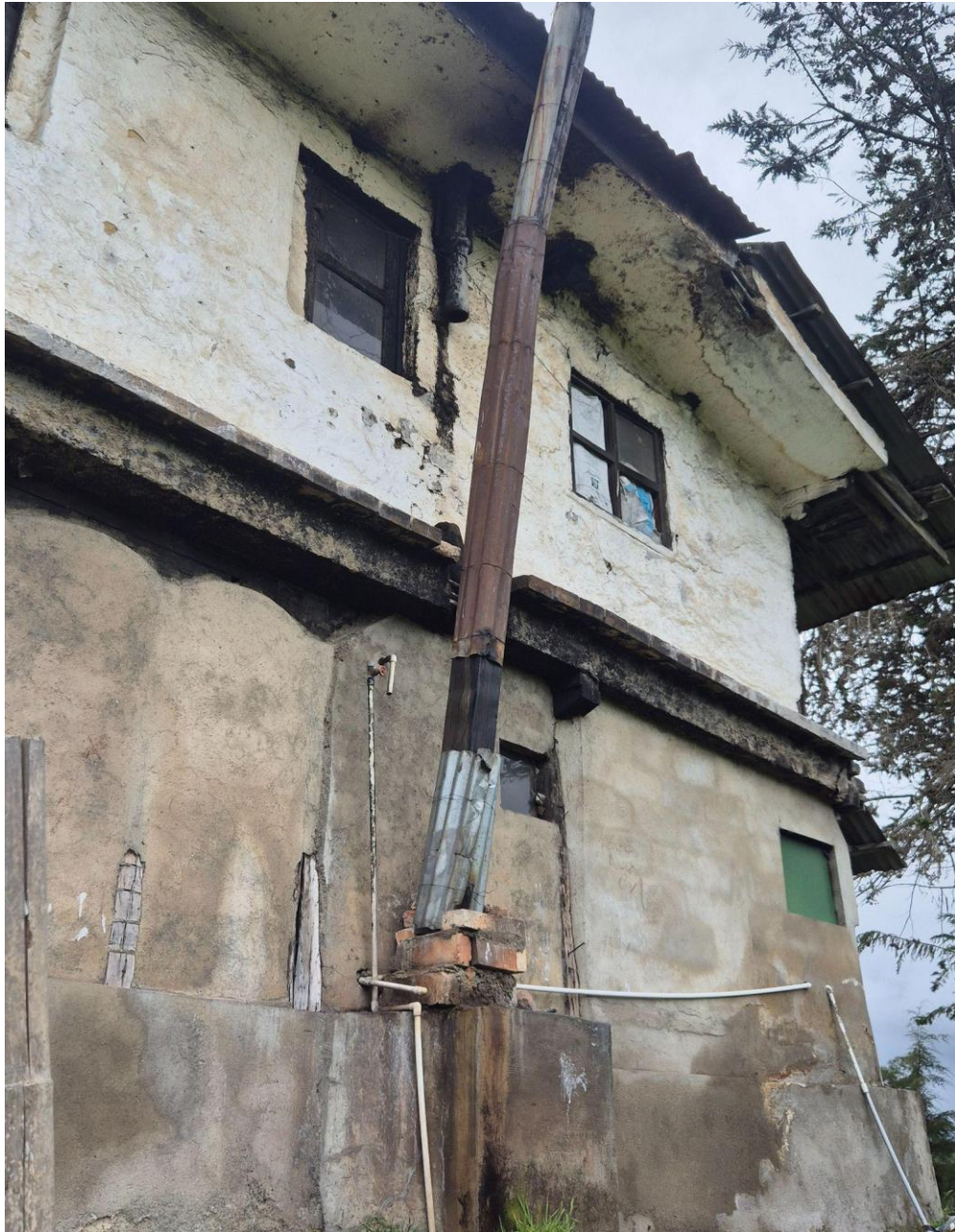
Nota. Escape del humo de la estufa. Hacienda Valencia. Tomado de Archivo de Paramografías [Fotografía] 2024.
