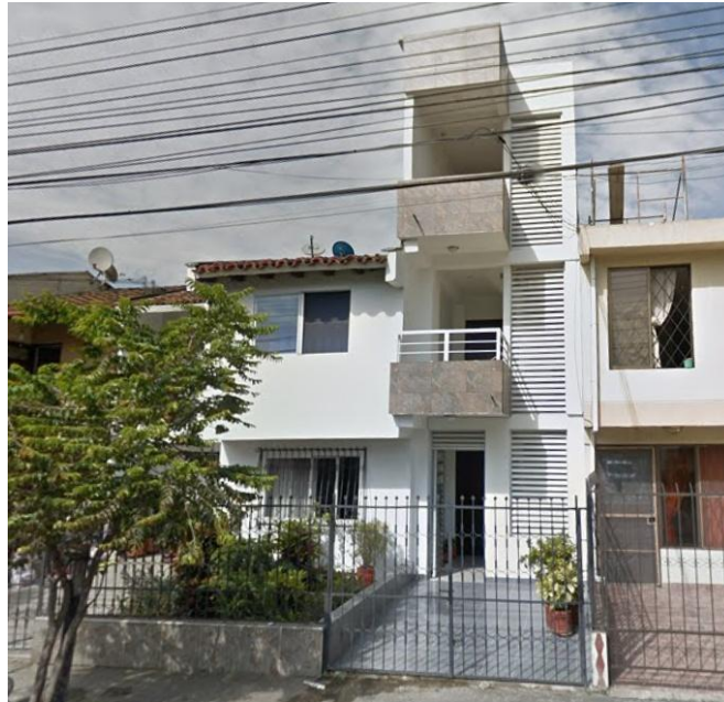
Figura 10. Fachada vivienda multifamiliar – Ciudad Capri
