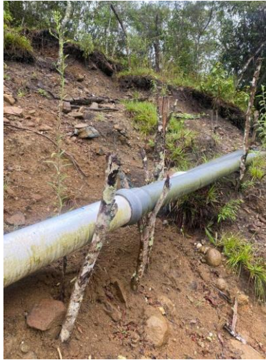
Ilustración 8. Soporte provisional de la tubería
