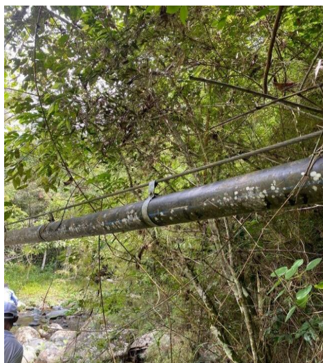
Ilustración 34. Tubería colgante de la quebrada Bitaco
