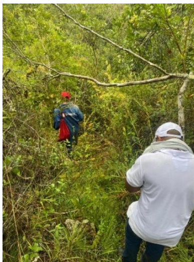
Ilustración 19. Vegetación presente sobre la tubería
