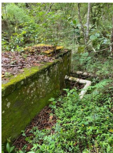
Ilustración 36. Desarenador quebrada Bitaco
