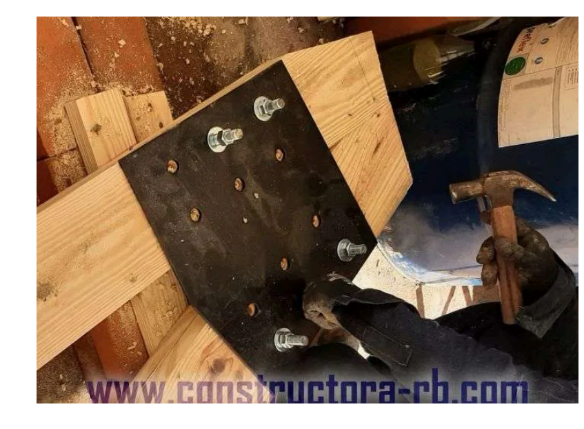
Platina de Acero Inoxidable Ensamble de Cercha
