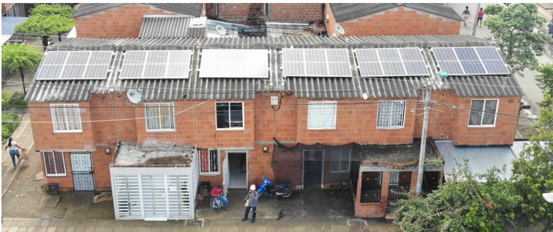
Figura 10. Viviendas con paneles solares instalados en barrio Potrero Grande, Comuna 21
