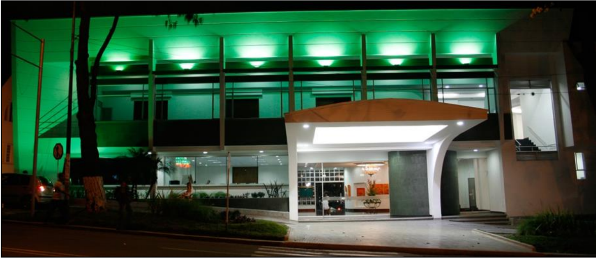
Figura 2. Fachada sede avenida circunvalar
