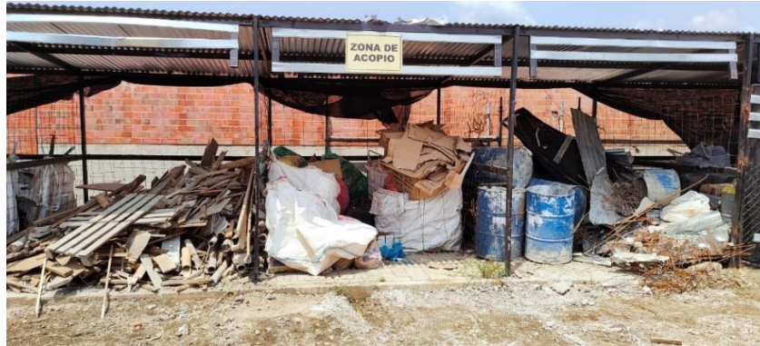
Figura 14. Sitio de acopio temporal.
