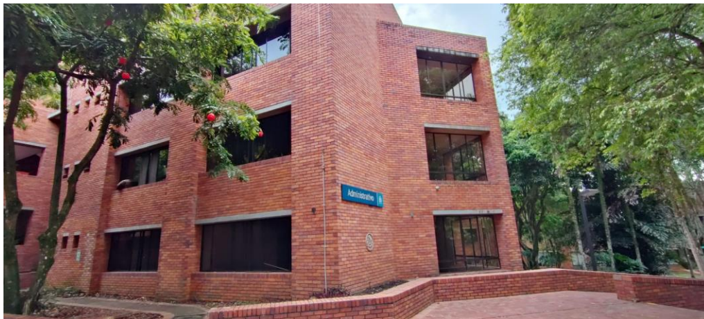
Figura 6. Vista de la fachada del edificio administrativo ala este de la Pontificia Universidad Javeriana sede Cali.
