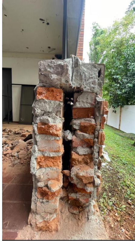
Figura 9. Mampostería doble en la fachada del edificio.
