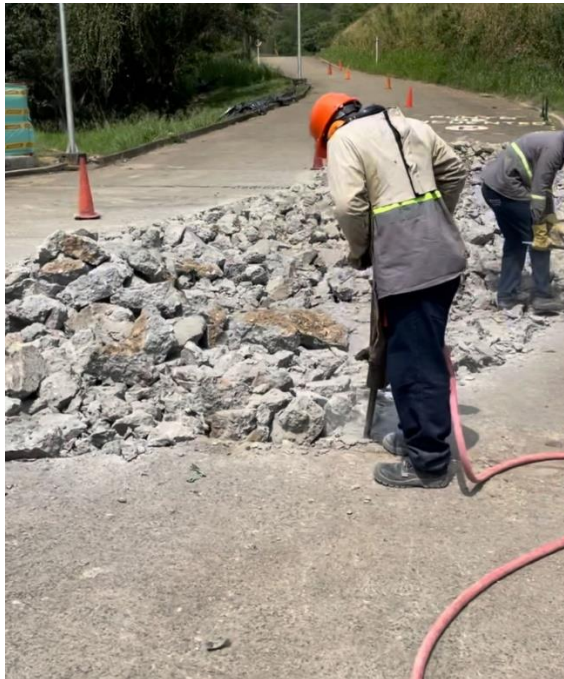
Figura 35. Demolición de vía existente con compresor y martillo demoledor.
