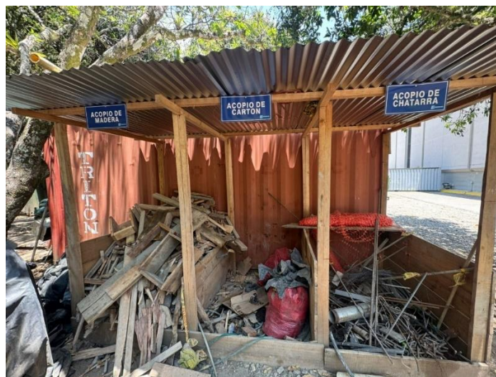
Figura 29. Almacenamiento temporal en obra de RCD.
