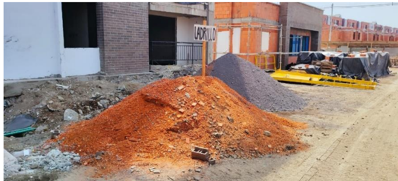
Figura 31. Separación en la fuente - Áreas señalizadas con su debido tipo de clasificación de residuos.
