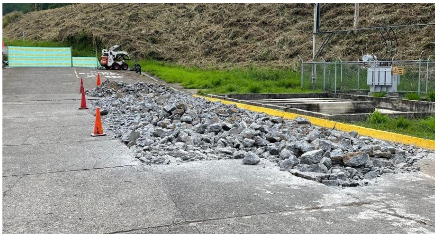
Figura 33. Demolición de losa de vía existente.
