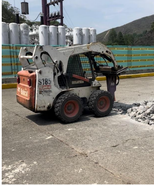
Figura 34. Demolición de vía existente con minicargador adaptado con martillo demoledor.
