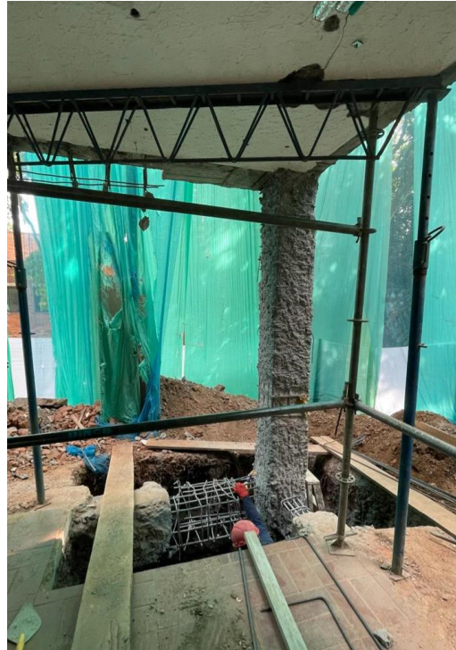
Figura 11. Apuntalamiento temporal con gatos y cerchas metálicas.
