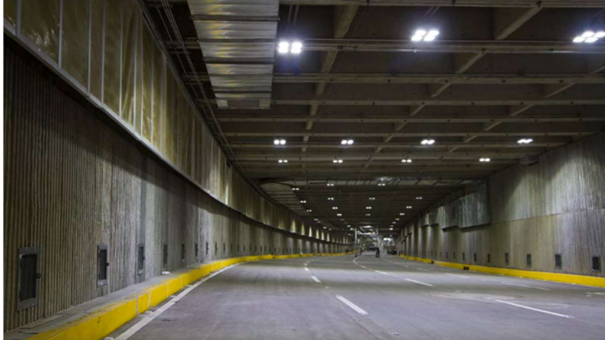
Figura 2 Vista interna del Túnel de la Avenida Colombia (Rosero Berrío, 2023).
