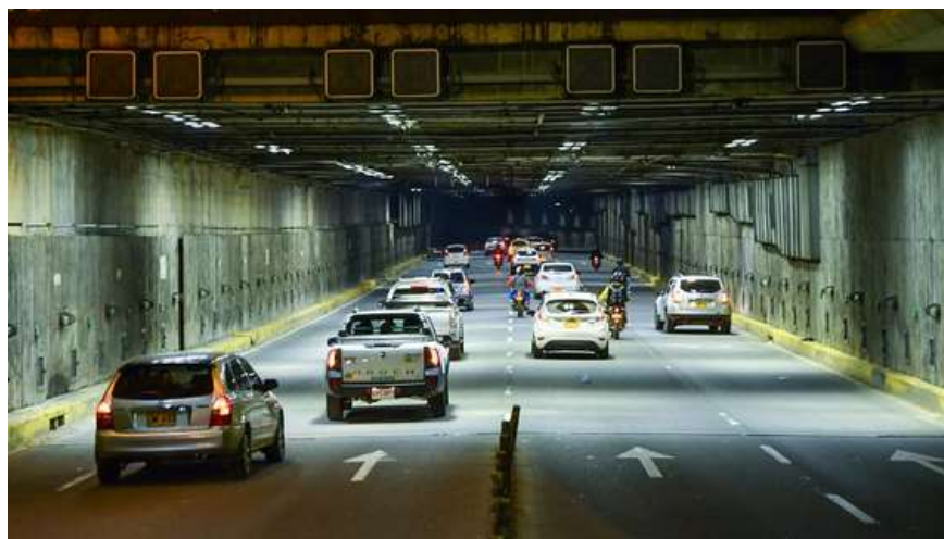
Figura 1 Vista general del Túnel de la Avenida Colombia (Rosero Berrío, 2023).
