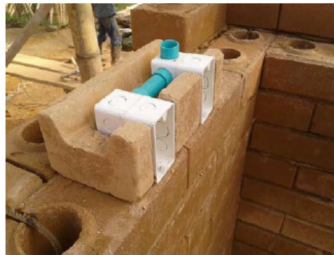
Ilustración 2. Bloque de Suelo cemento en Obra. Tomado de: (Bedoya-Montoya, 2018).
