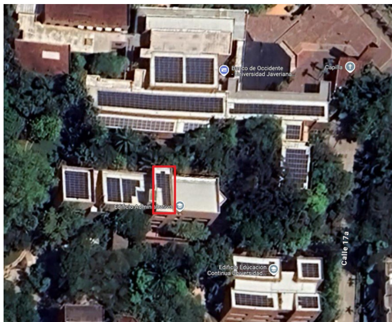
Figura 2. Sistema FV edificio administración PUJ Cali
